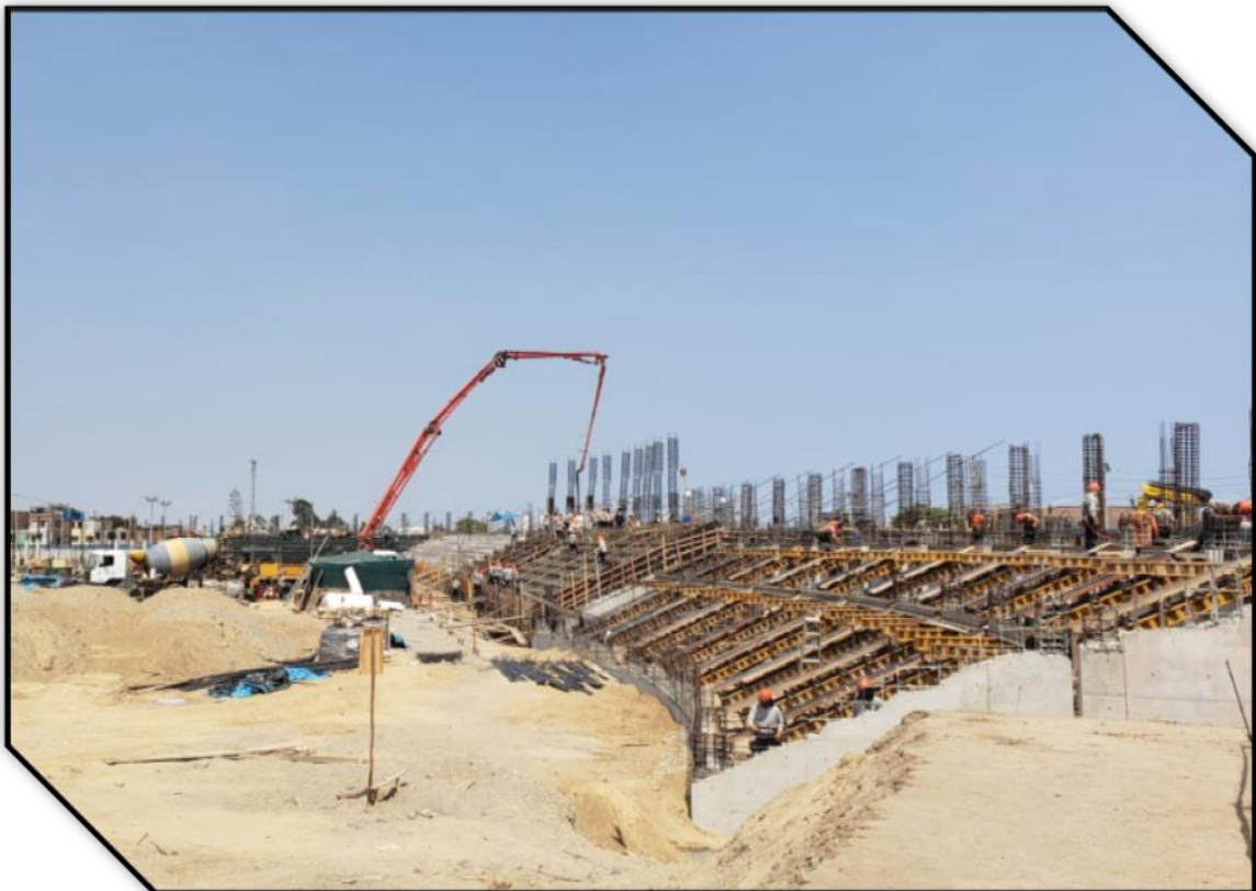
VISTA 03.- TRABAJOS DE ENCOFRADO METALICO Y HABILITACION DE ACERO EN GRADERIAS.
