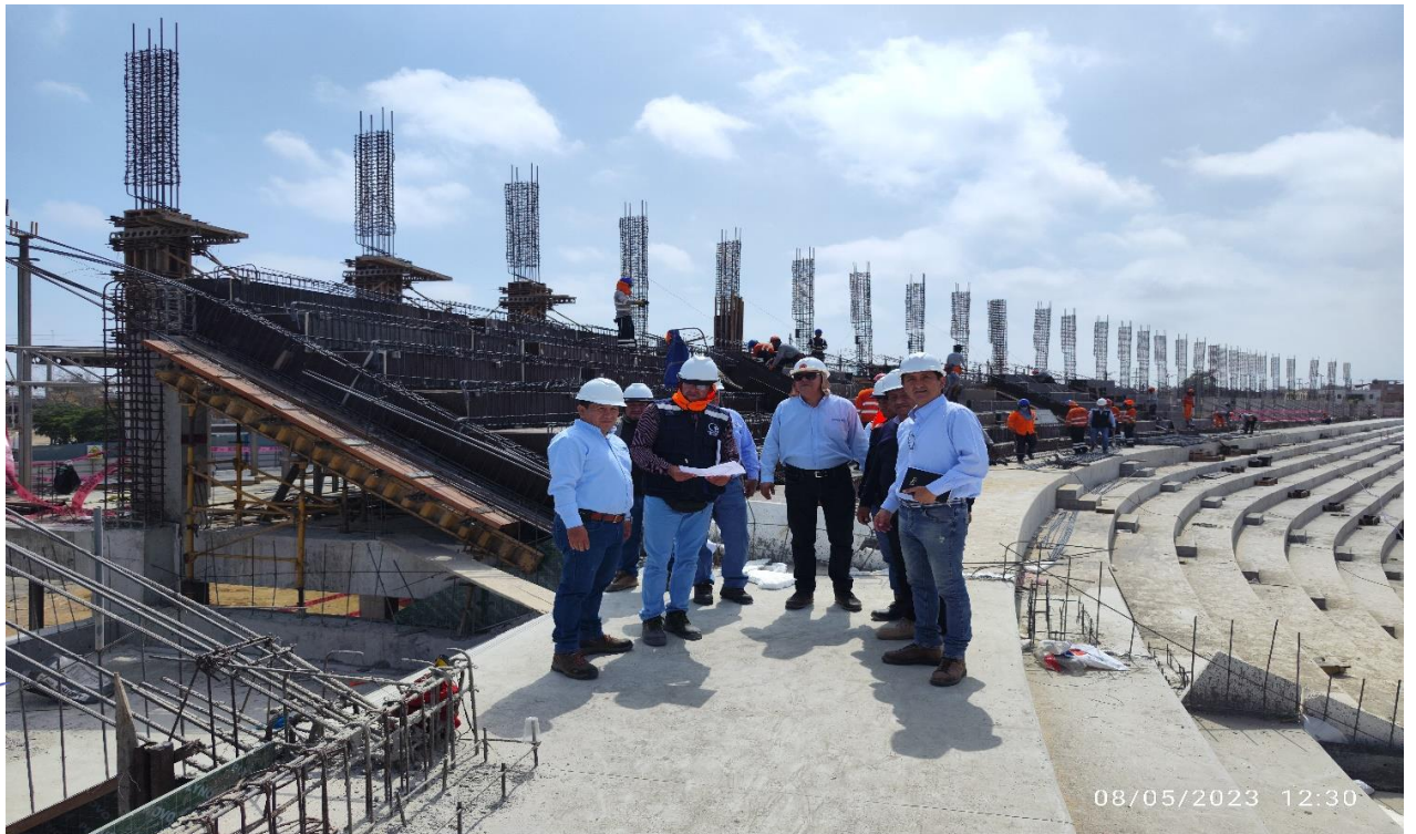
VISTA 03.- TRABAJOS DE ENCOFRADO METALICO Y HABILITACION DE ACERO EN GRADERIAS.
