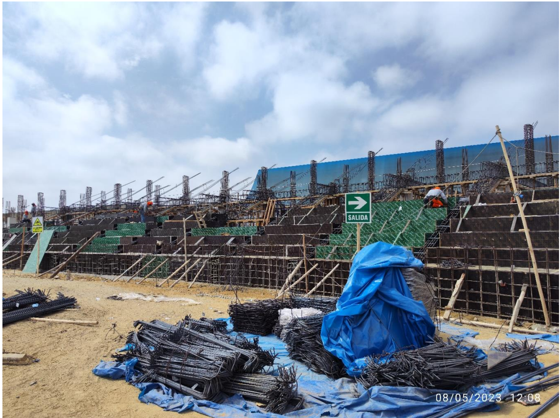
VISTA 03.- TRABAJOS DE ENCOFRADO METALICO Y HABILITACION DE ACERO EN GRADERIAS.
