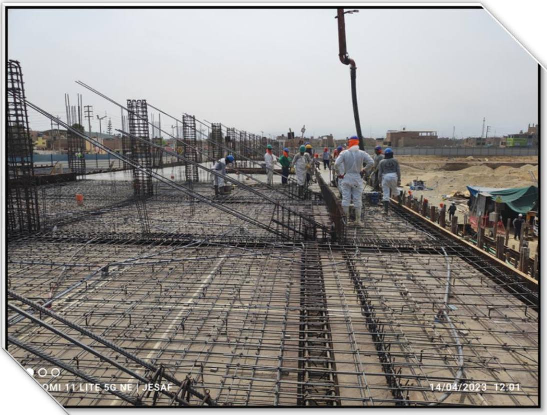
VISTA 02.- VACIADO DE CONCRETO TRIBUNA ORIENTE.
