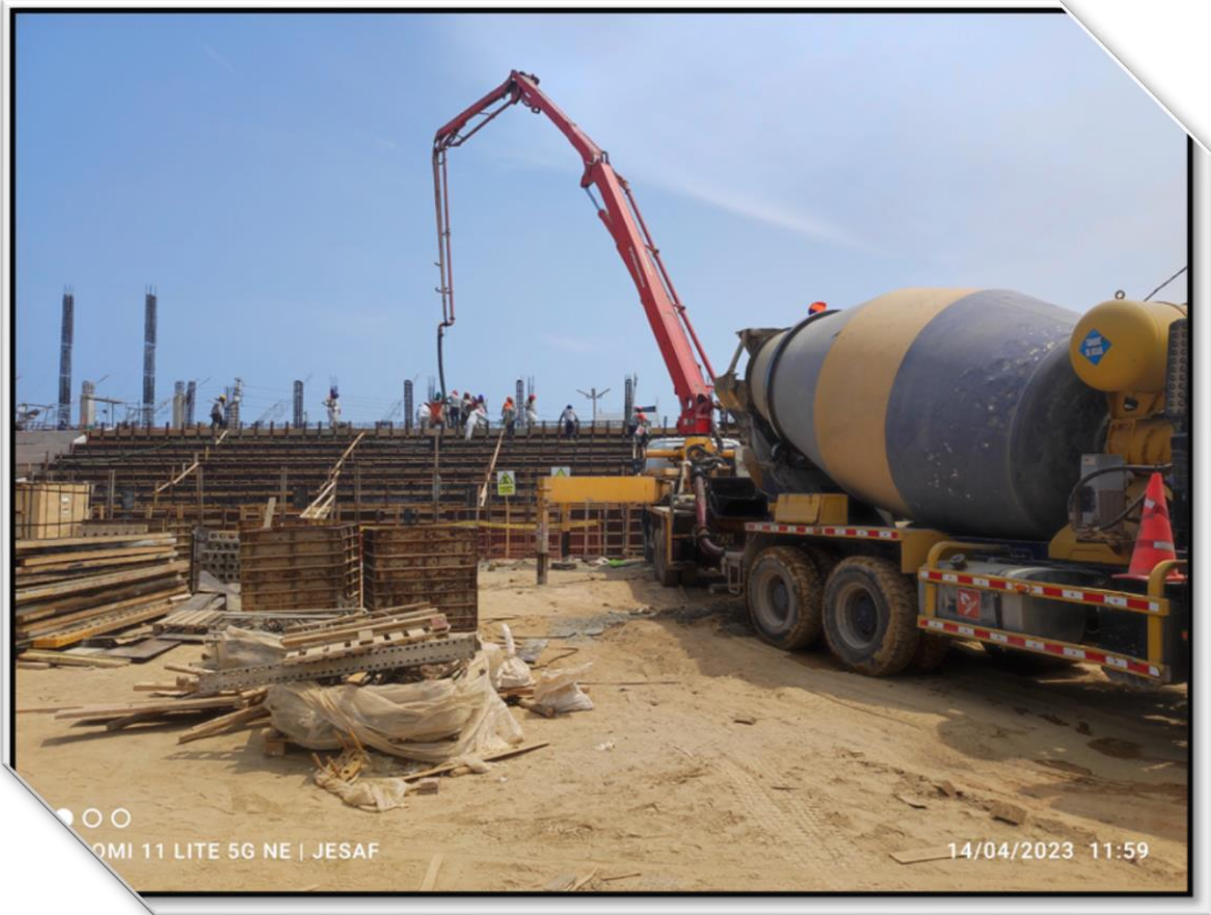
VISTA 02.- VACIADO DE CONCRETO TRIBUNA ORIENTE.
