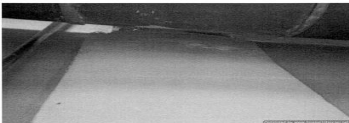
Falta uniformizar acabado de tarrajeo de elementos verticales con mortero ignifugo; considerando que un mismo tramo se tiene diferentes espesores visibles
