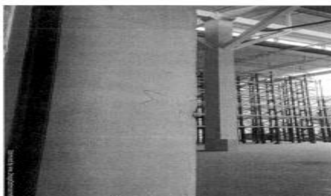
Resane de mortero ignifugo inconclusas, en esquina de columna
