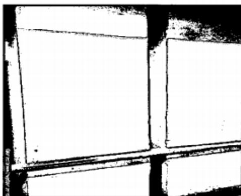
Resane de mortero ignifugo inconclusas, en esquina de columna
