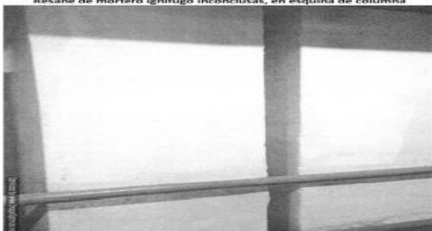
Resane de mortero ignifugo inconclusas, en esquina de columna
