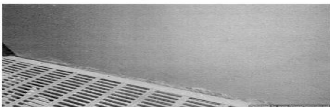
Falta mejorar acabado en encuentro de muros y pisos
