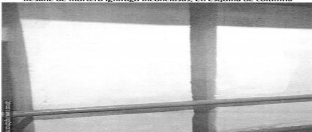
Resane de mortero ignifugo inconclusas, en esquina de columna
