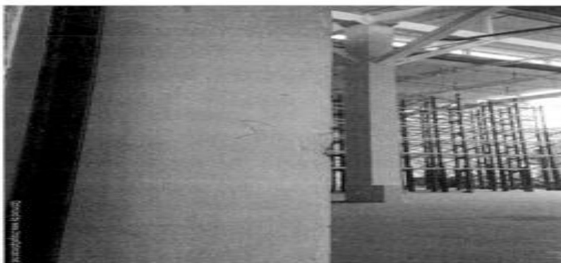
Resane de mortero ignifugo inconclusas, en esquina de columna
