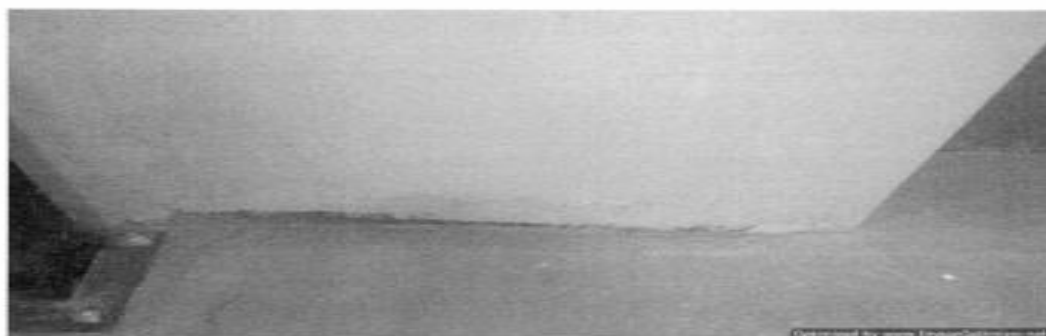
Falta mejorar acabado en encuentro de muros y pisos
