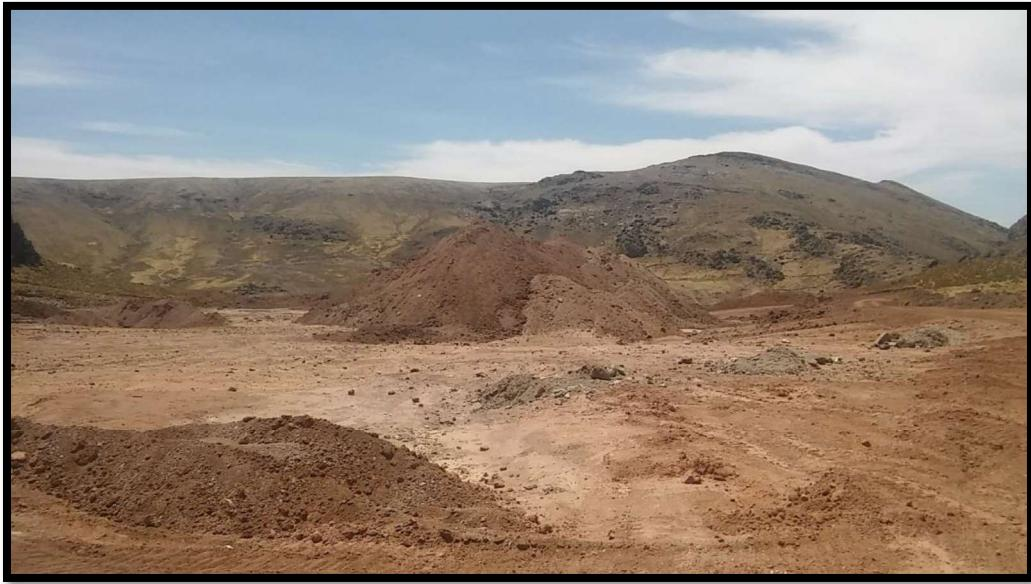
24. Como se puede apreciar la partida 2.04.02, se refiere concretamente a la extracción del material (GP-GC), para la construcción del cuerpo de la presa.
